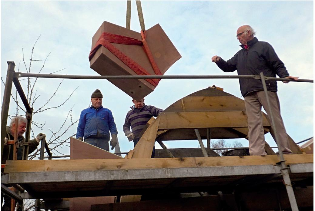
*In genauem Neigungswinkel werden die weiteren Steine auf dem Leergerüst aufgelegt*
