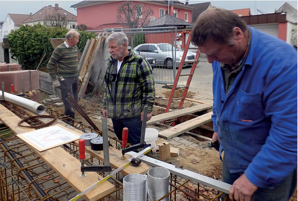
*Der Korb mit den Aussparungen für die Verankerungen wird genau nach Plan vorbereitet*
