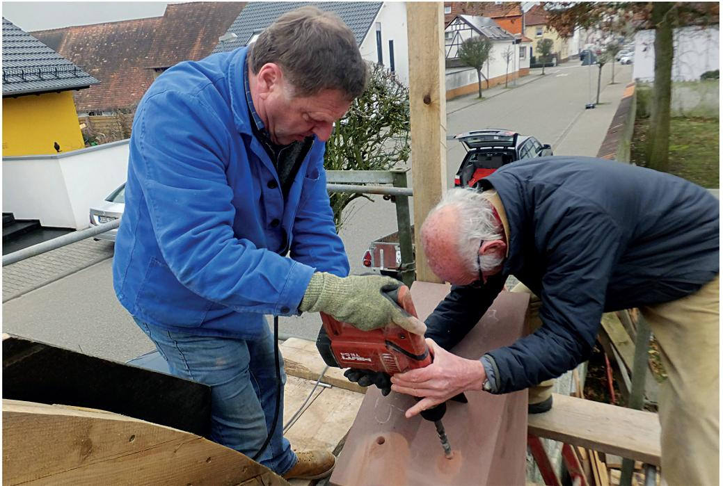
*Die Löcher für die Verbindungs-Anker werden gebohrt*
