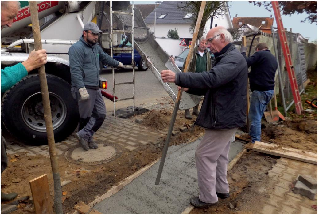
*Der Beton wird in das Fundament eingegossen*
